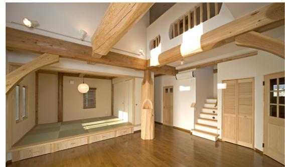
一般的な構造材の約4倍の断面積を持つ八寸角材を用いた、丈夫な大断面の家
